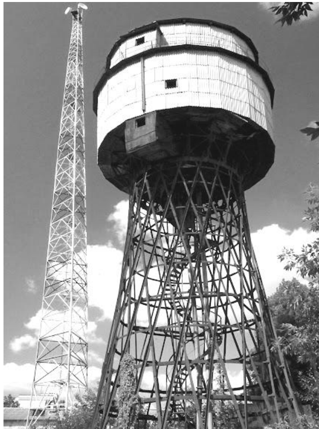
«Гіперболоїдна» водонапірна вежа, зведена на початку ХХ ст. за проектом всесвітньовідомого конструктора В.Г. Шухова. Пам'ятка архітектури щойновиявлена у 2008 р. та втрачена (зруйнована) близько 2010 р.
